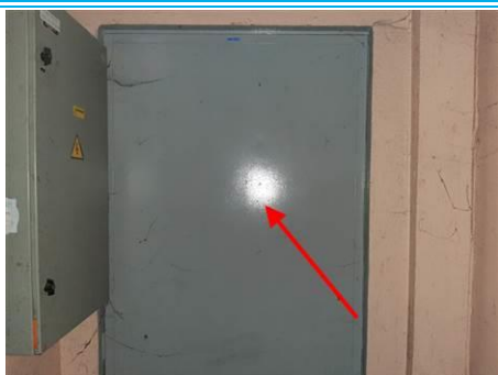
Photo n° PhPb003 Localisation : Sous-sol - 10 UD : Porte (partie basse) Type de dégradation : NC - Substrat : Métal - Revêtement : Peinture - Mesure : 5,17
