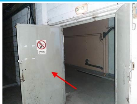
Photo n° PhPb004 Localisation : Sous-sol - 14 UD : Porte (partie basse) Type de dégradation : NC - Substrat : Métal - Revêtement : Peinture - Mesure : 2,93
