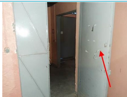
Photo n° PhPb002 Localisation : Sous-sol - 08 UD : Porte (partie basse) Type de dégradation : NC - Substrat : Métal - Revêtement : Peinture - Mesure : 3,12
