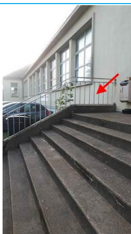
Photo n° PhPb007 Localisation : Extérieur - Façade UD : Main-courante (mesure 1) Type de dégradation : NC - Substrat : Métal - Revêtement : Peinture - Mesure : 2,99
