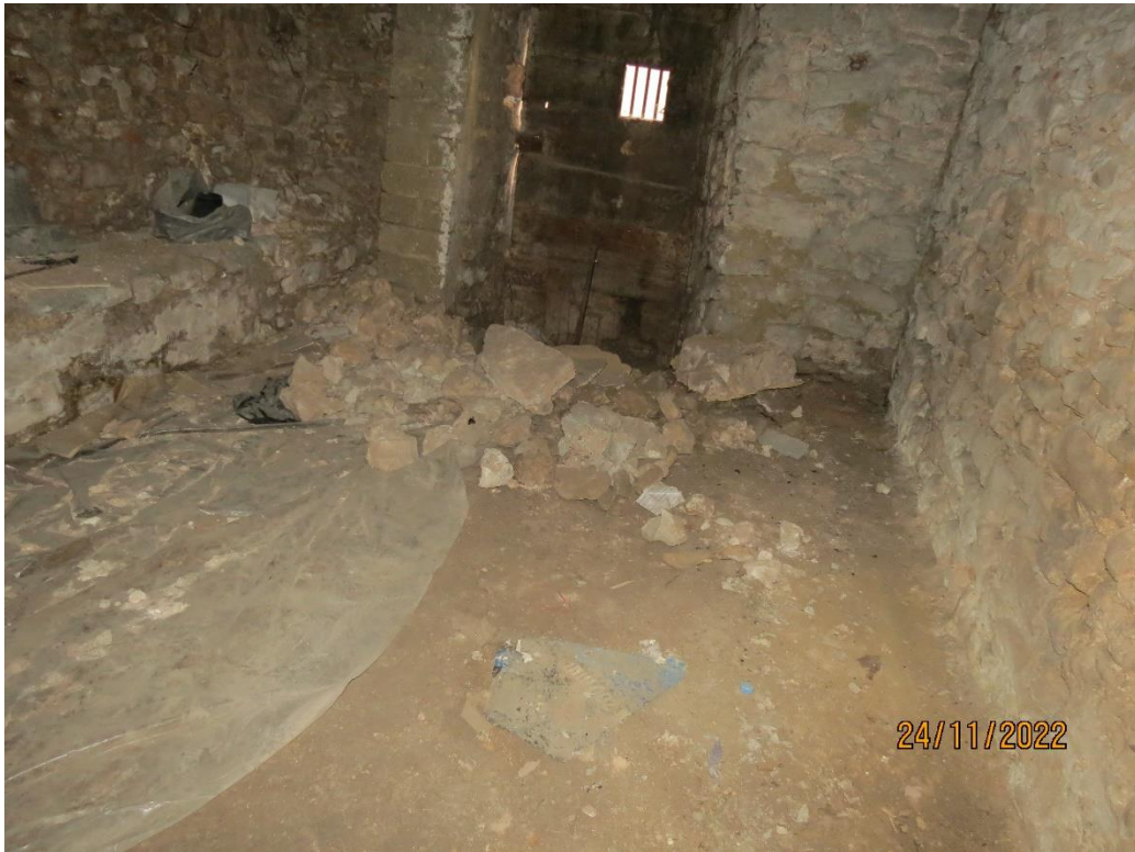
Chute des moellons détachés du mur.
