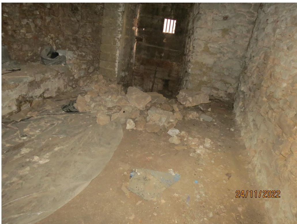
Chute des moellons détachés du mur.
