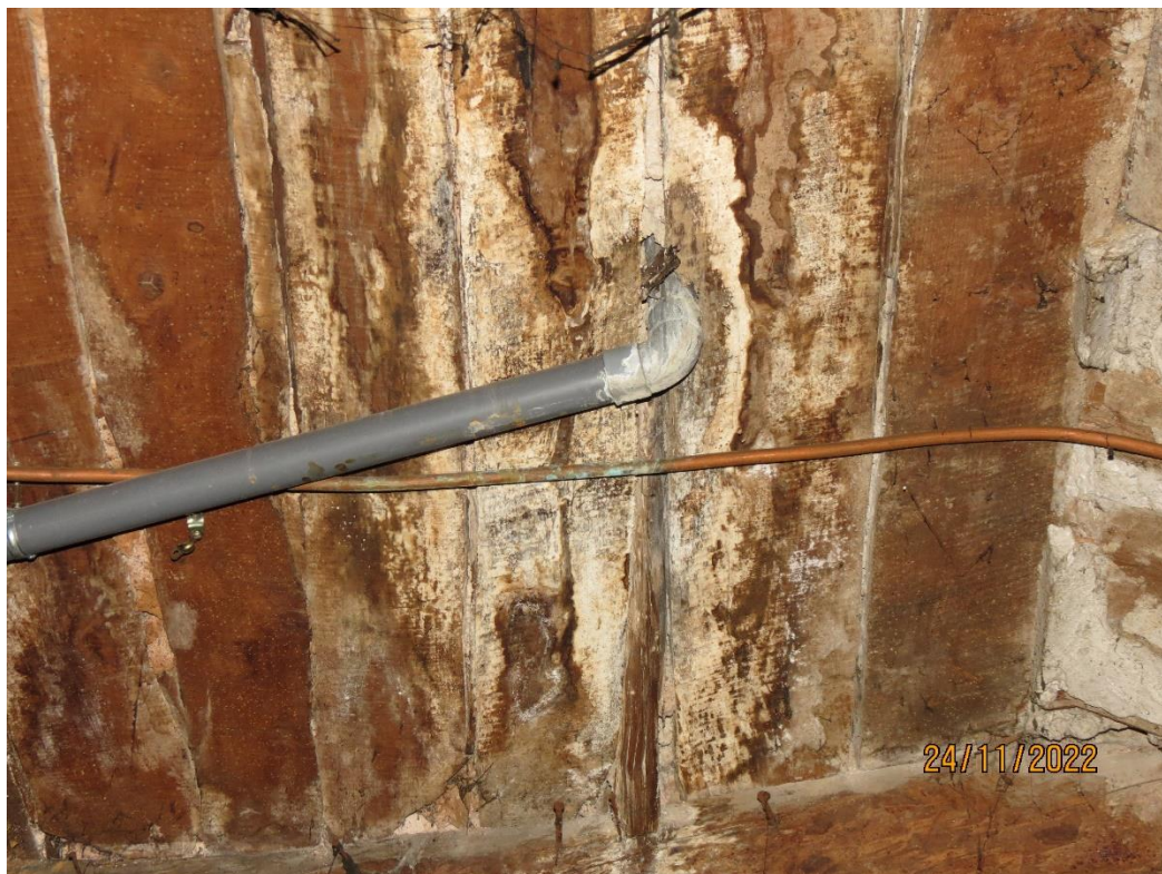
Partie du plafond, avec des lattes à remplacer, descente du syphon de sol
