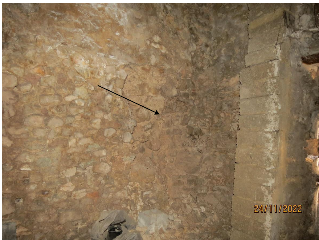
Perte d'une partie de la surface du mur près du soubassement
