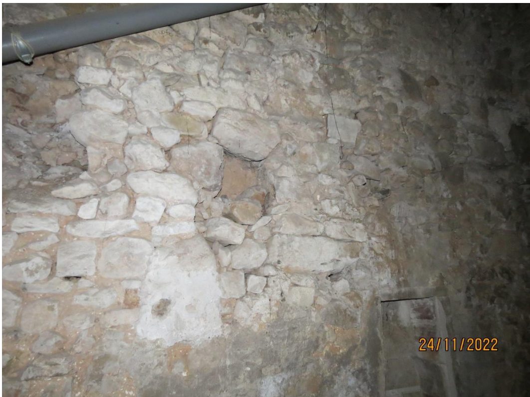
Déscellement des moellons généralisé par désagrégation des liants qui se transforme en poussière, rendant la structure sans cohésion.
