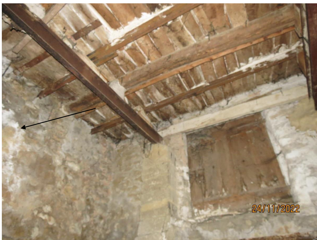
Idem en partie haute, je note une grosse infiltration d'eau venant de la place
