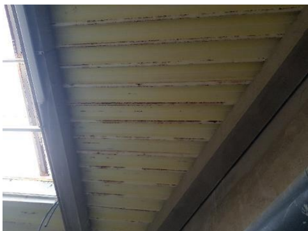
- Décollement de peinture et corrosion sur bacs acier
