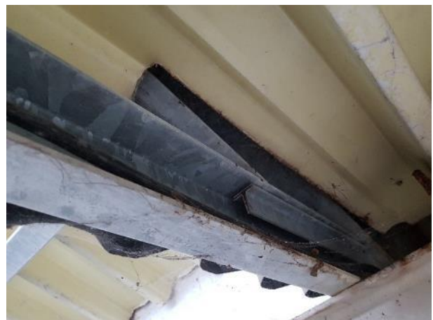
Photo de l'entrait d'une ferme de rive
