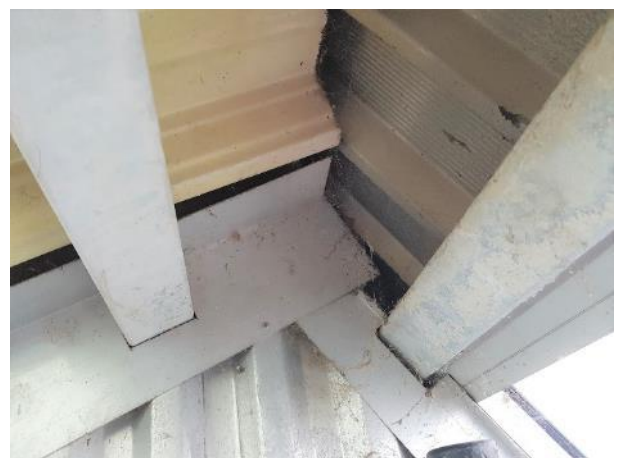
Photo de la jonction des bacs acier nervurés au droit du faitage
