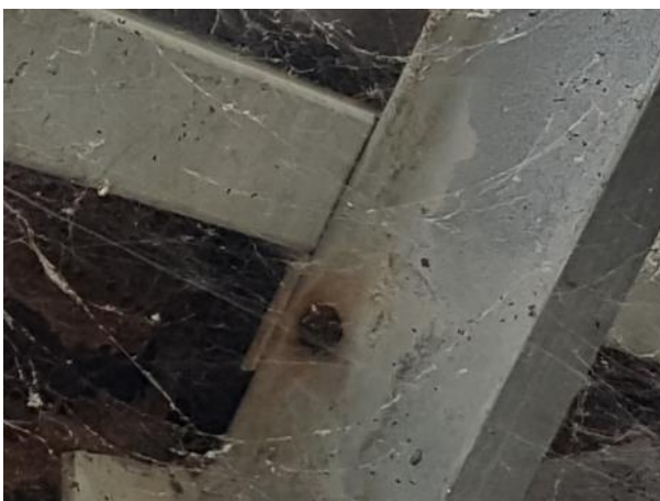
Photo de fixation d'une panne sur arbalétrier par équerre boulonnée
