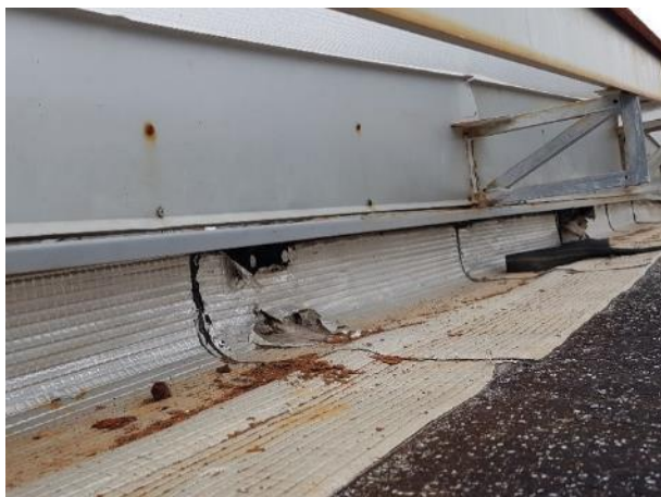
- Bande de relevé d'étanchéité détériorée au droit de chaque fixation d'entretoise de trémie
