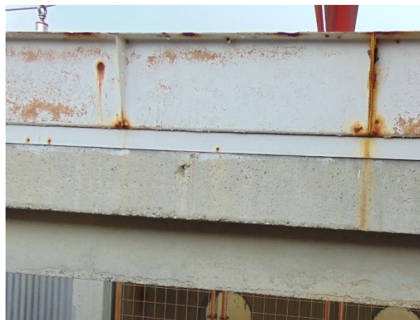
D4 - Eclat de béton sur poutre S5
