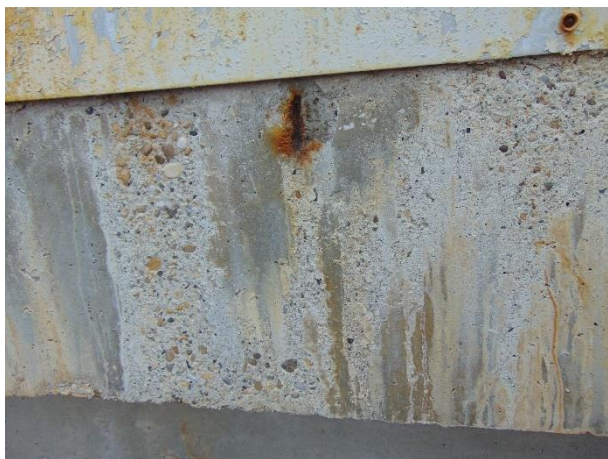
D3 - Acier corrodé sur poutre S2
