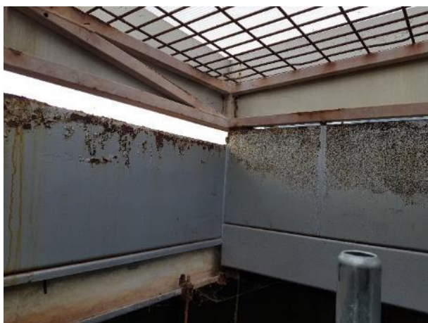
- Décalage vertical des pièces de chevêtre et descostières de trémie de verrière
