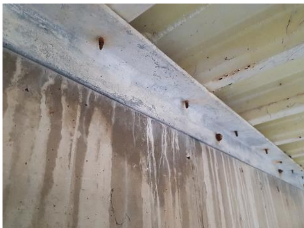
Bac acier en appui sur cornières 60x60x5 file 6
