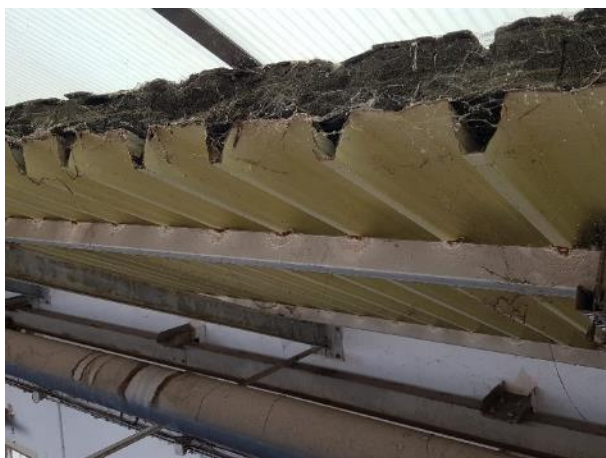
Photo du bac acier et de l'isolant du grand versant
