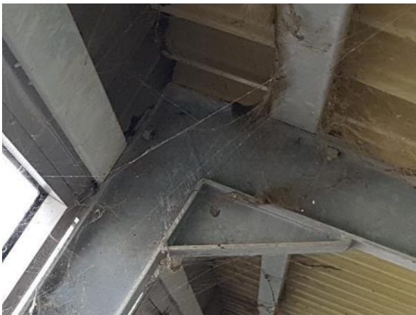
Photo de l'assemblage des arbalétriers par gousset
