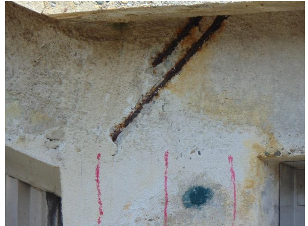
D6 - Aciers corrodés en tête de poteau S11
