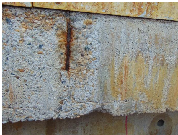
D2 - Acier corrodé et fissure longitudinale sur poutre S1
