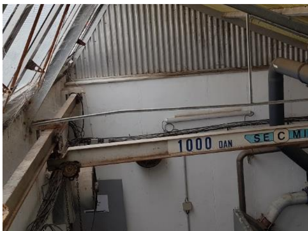
- Déformation de l'entrait de ferme
