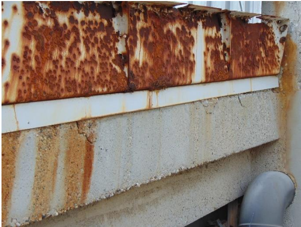
D5 - Eclats de béton sur poutre S9
