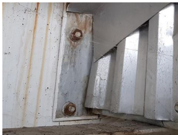
- Point de corrosion sur ecrous de fixation
