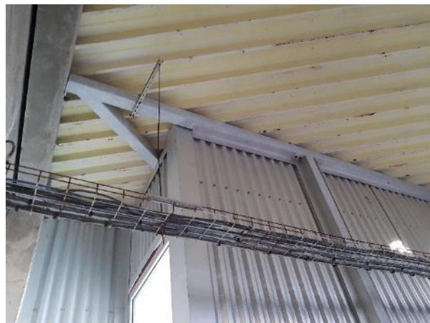
Bac acier en appui sur pannes tubulaires 100x100 mm
