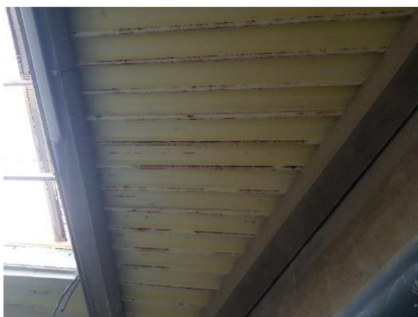
Bac acier en appui sur les poutres en béton armé
