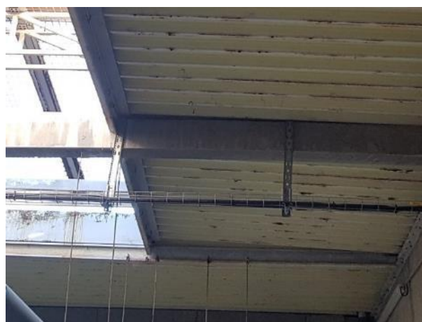
Bac acier en appui sur linéaires de trémie
