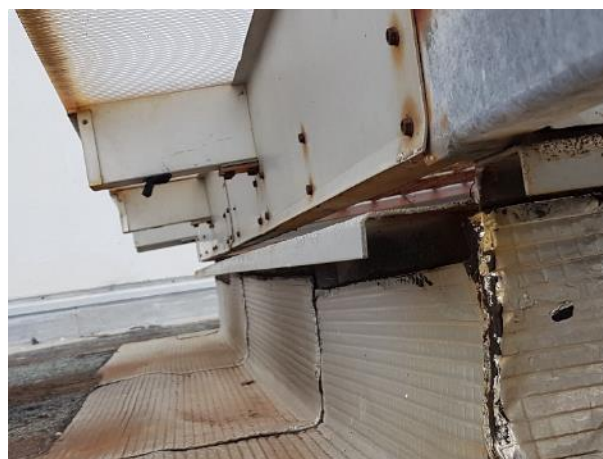
- Décalage vertical des costières de trémie de verrière
