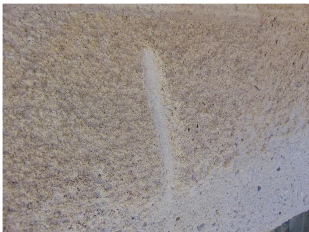
D1 - Béton pulvérulent
