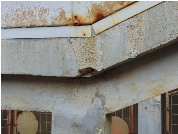
D7 - Acier corrodé et éclat de béton au droit de S13
