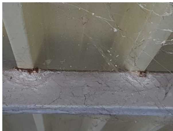
- Points de rouille sur pannes au contact du bac acier
