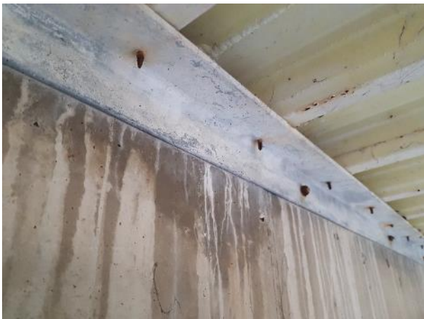
- Traces d'infiltrations d'eau sur mur de refend
