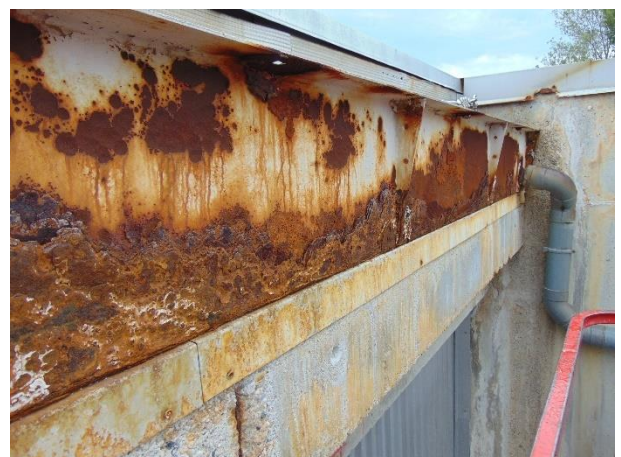
D10 - Cheneau métallique corrodé
