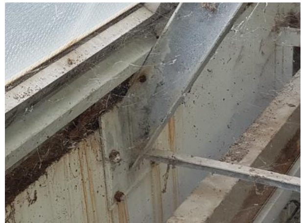
Photo de la fixation par platine et boulons de la ferme sur refend en béton
