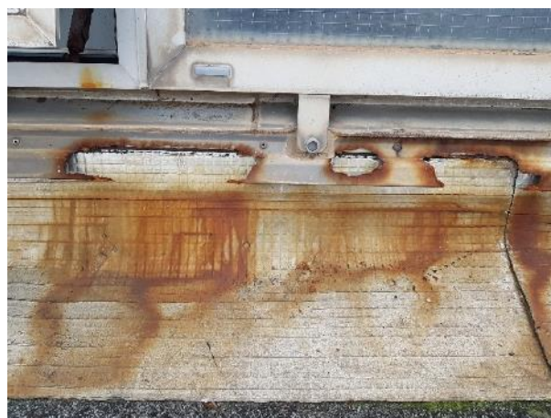
- Corrosion de la bande solin en pied de versant Nord
