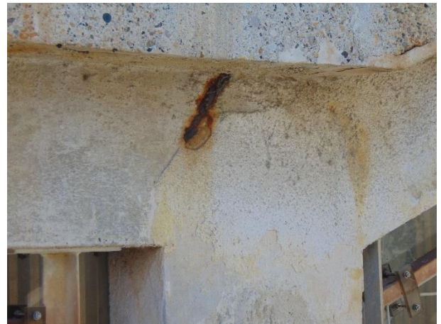
D8 - Acier corrodé en tête de poteau S15
