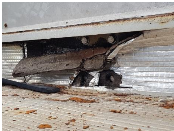
- Bande de relevé d'étanchéité détériorée
