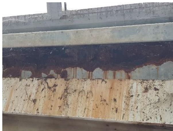
- Corrosion de la costière en tôle en pied de versant Nord et coulures de rouille sur murs en béton
