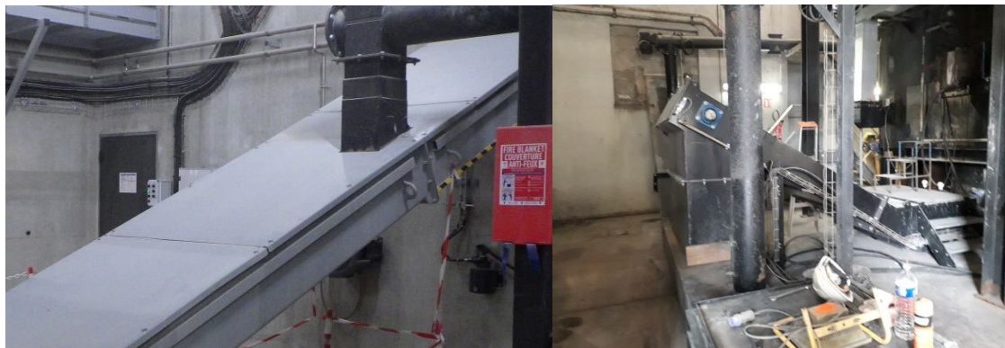
Figure 7. Exemple de convoyeur cendre sous foyer capoté
