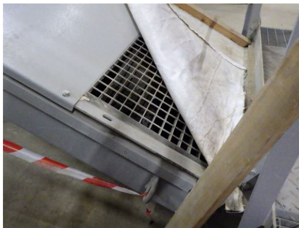
Figure 3. Exemple de grille de surveillance nécessitant l'ajout d'une trappe étanche - Risque de projection
