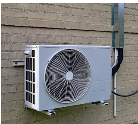
Mise en place de pompes à chaleur individuelles pour le chauffage
