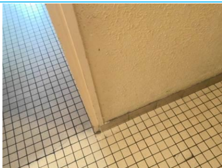
Matériaux : ZPSO-033 Prélèvement : P034 Description : Enduits à base de plâtre Localisation : Rez de chaussée - Dgt Résultat : Absence d'amiante
