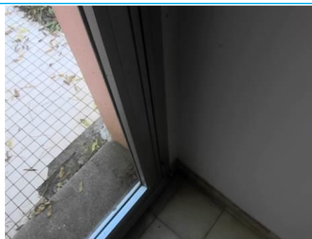
Matériaux : ZPSO-006 Prélèvement : P006 Description : Colle de carrelage (plinthes) Localisation : Rez de chaussée - Séjour Résultat : Absence d'amiante
