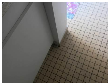
Matériaux : ZPSO-002 Prélèvement : P002 Description : Colle de carrelage (plinthes) Localisation : Rez de chaussée - Cuisine Résultat : Absence d'amiante
