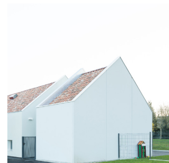
Descentes d'eaux pluviales non-visibles pensées dans l'écriture architecturale
