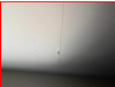
Matériaux : ZPSO-027 Prélèvement : P028 Description : Bandes calicot Localisation : Rez de chaussée - BP service Résultat : Présence d'amiante
