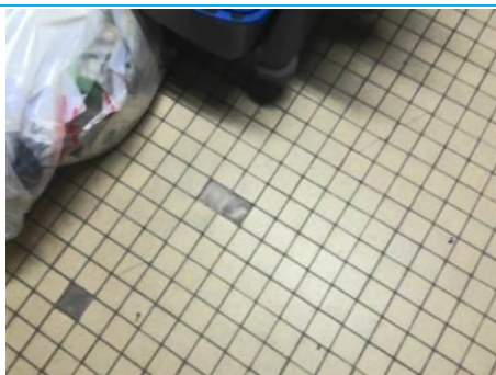
Matériaux : ZPSO-037 Prélèvement : P038 Description : Colle de carrelage Localisation : Rez de chaussée - Garage Résultat : Absence d'amiante
