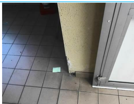
Matériaux : ZPSO-028 Prélèvement : P029 Description : Colle de carrelage (plinthes) Localisation : Rez de chaussée - Tri départ Résultat : Absence d'amiante
