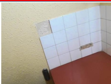
Matériaux : ZPSO-029 Prélèvement : P030 Description : Colle de faïence Localisation : Rez de chaussée - Repos Résultat : Absence d'amiante
