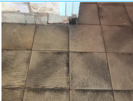
Matériaux : ZPSO-001 Prélèvement : P001 Description : Colle de carrelage (plinthes) Localisation : Rez de chaussée - Guichet public Résultat : Absence d'amiante
