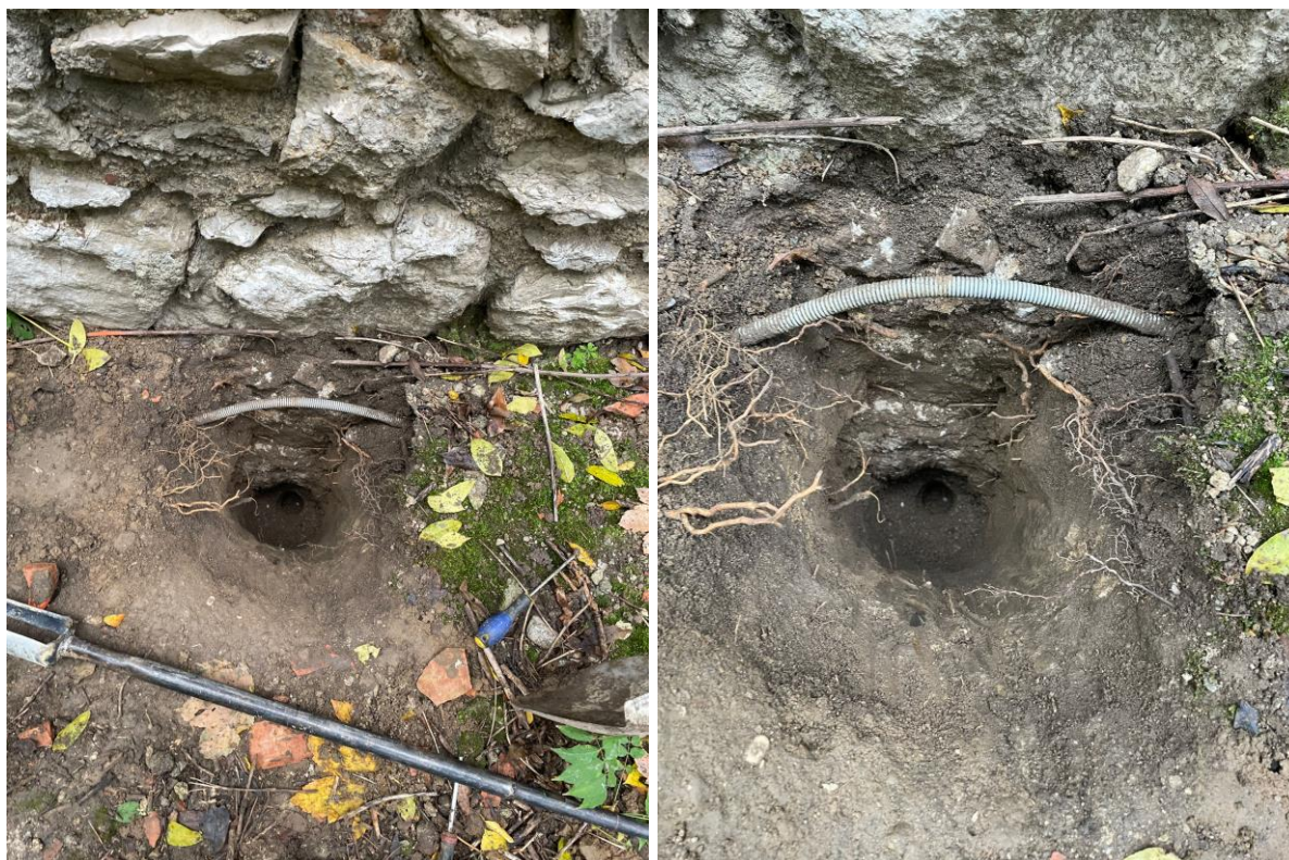
Figure 15 : Photographies du sondage de reconnaissance de fondations - 23/11/2022
