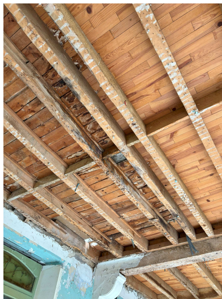
Figure 7 – Dégradation plancher repère 4
