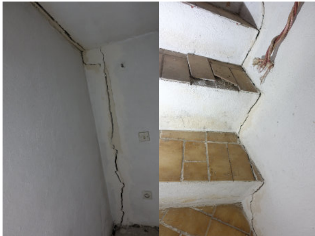
Fissuration centimétrique
