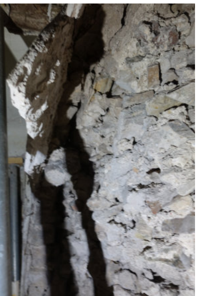
Maçonneries de petits moellons. Absence d'élément d'harpage
