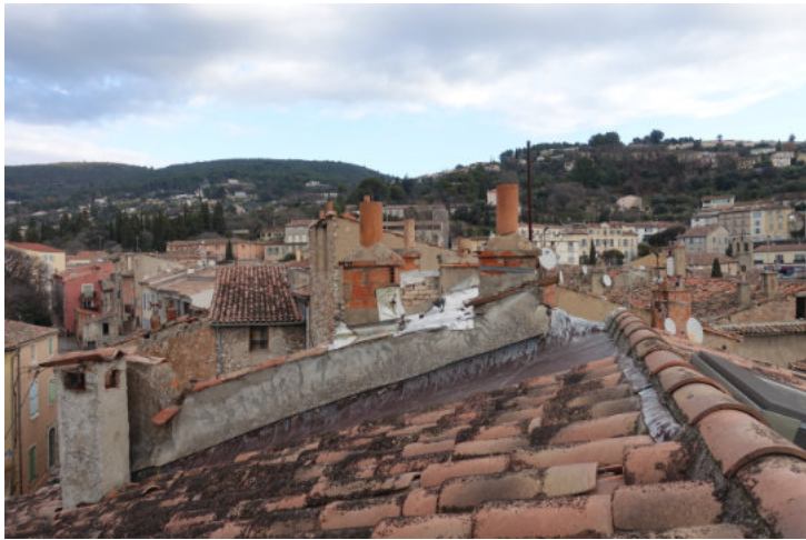
Tuiles glissées, solin à vérifier
