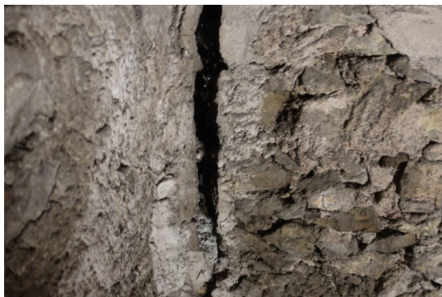
Disjonction entre les murs de refends Nord et Est
