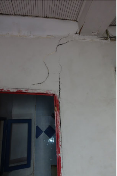
Fissuration du au mur effondré
