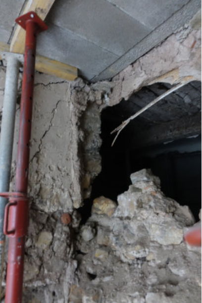
Plancher poutrelle hourdis implanté dans le mur de refend effondré à la jonction avec le 46 rue de l'observance
