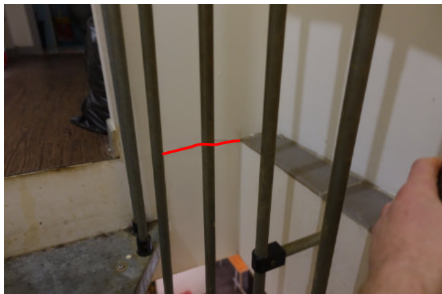
Fissuration millimétrique
