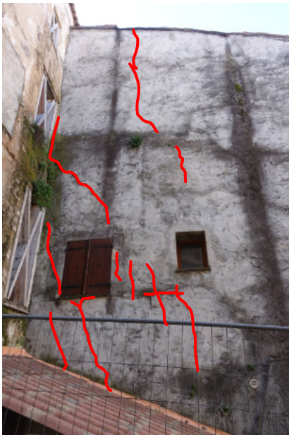
Fissuration plurimillimétrique voire centimétrique
