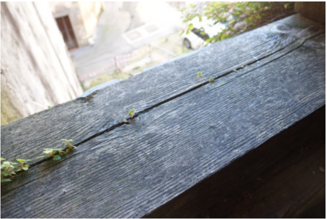
Végétation implantée dans le bois d'étrésillonnement
