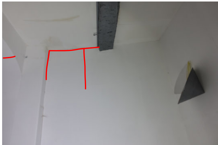
Fissuration millimétrique, trace d'humidité
