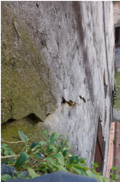
Désaffleur de l'enduit et des maçonneries
