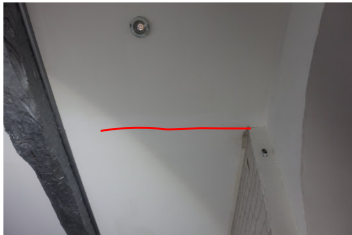
Fissuration millimétrique
