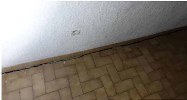
Fissuration centimétrique
