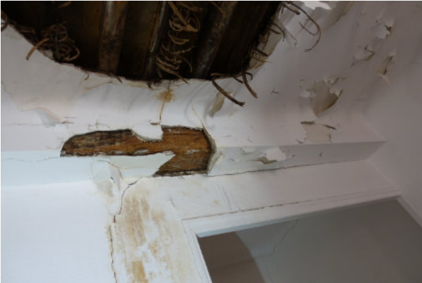
Enduit plâtre autour de la solive effondré
