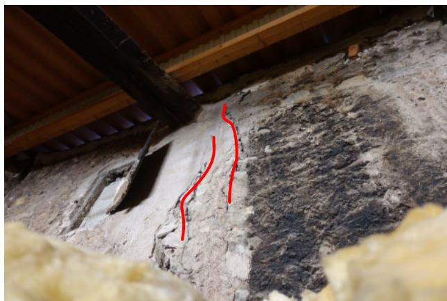
Fissuration pluri-millimétrique
