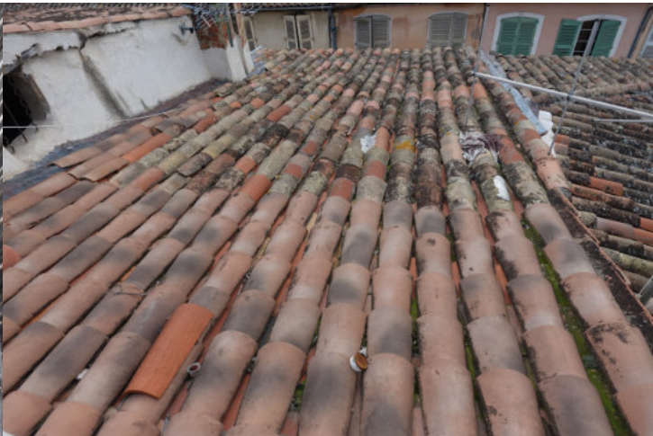
Tuiles glissées, végétation dans les tuiles de courant, divers objet, toiture sur quartons.
