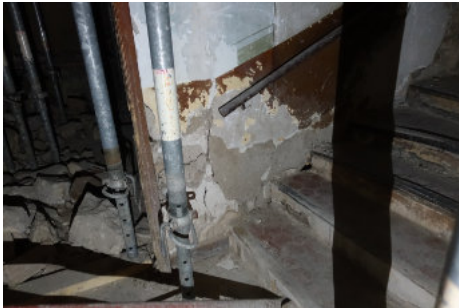
Cloison d'escalier très altérée
