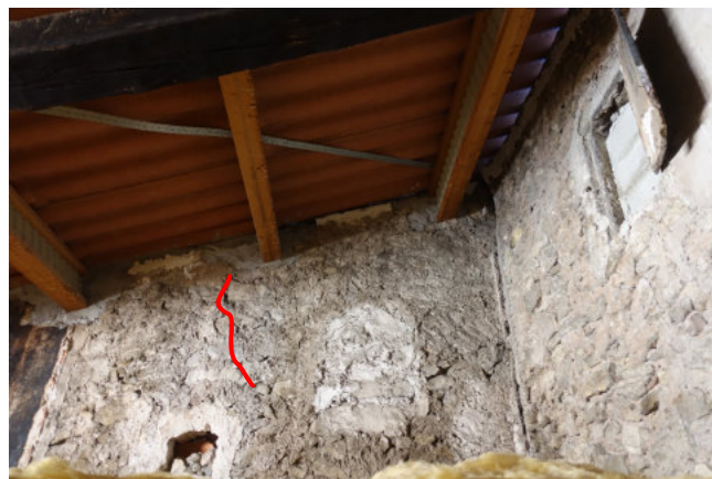
Fissuration pluri-millimétrique
