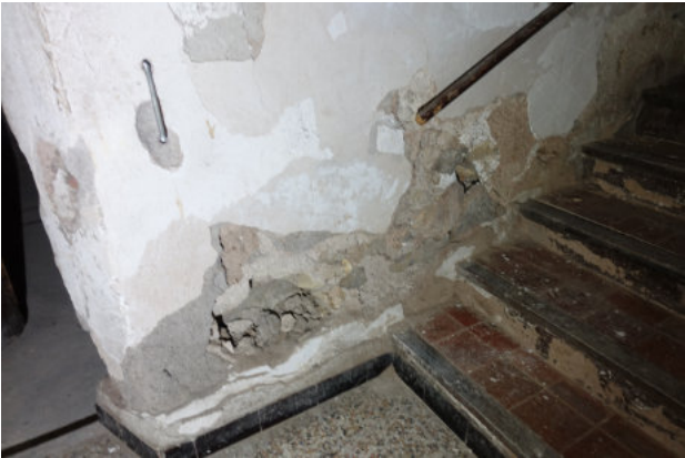
Mur d'escalier très altérée
