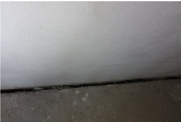
Disjonction centimétrique de la dalle béton
