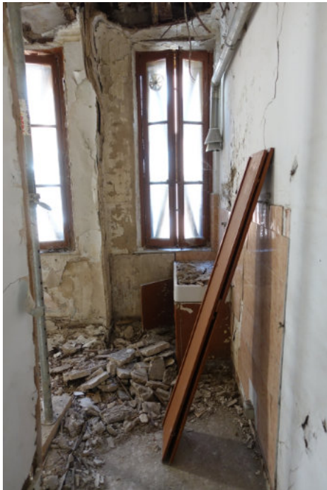
Faux plafond effondré et gravats sur plancher
