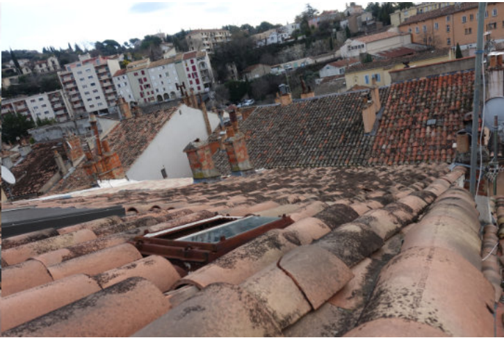
Tuiles glissées, végétation dans les tuiles de courant, divers objet, toiture sur quartons, tuiles cassées
