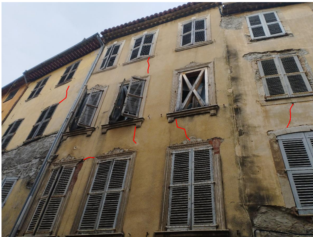
Vue des fissures qui affectent les façades des n°48, 46 et 44
