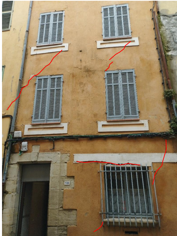
Vue des fissures qui affectent la façade du n°50
