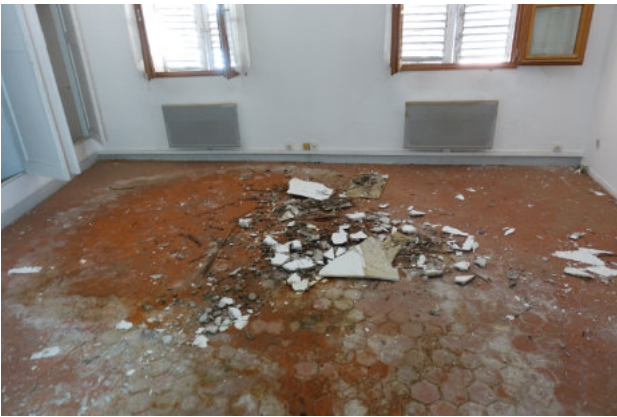
Débris d'effondrement du faux plafond, trace d'humidité
