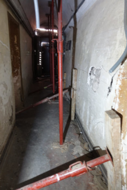
Bouffement important des maçonneries
