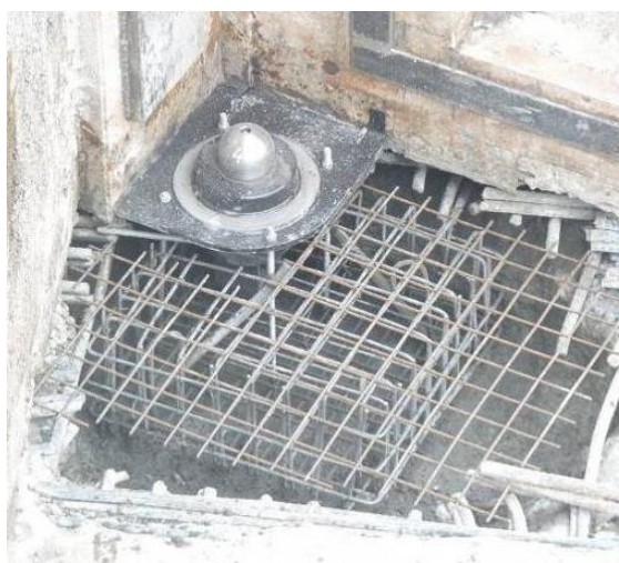
Figure 17 : Exemple de pivot avant scellement dans son massif de fondation
