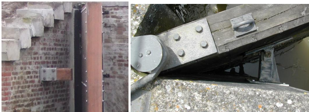
Figure 21 et 22 : Exemples de butées latérales
