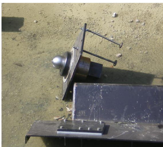
Figure 16 : Exemple de pivot à sceller et protection de chardonnet
