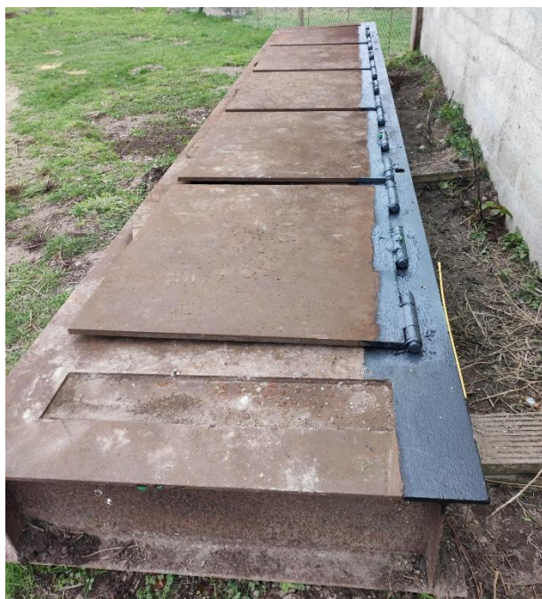
Figure 11 : Partie basse du batardeau munie de clapets
