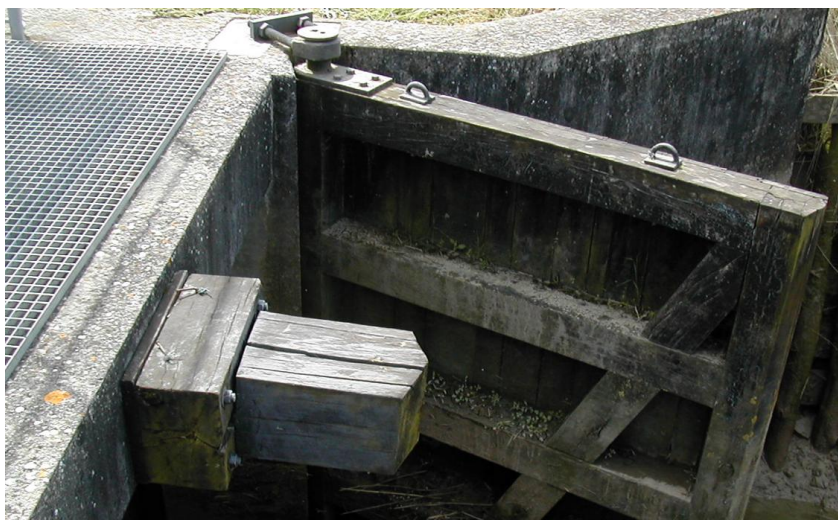
Figure 20 : Exemple de butée supérieure
