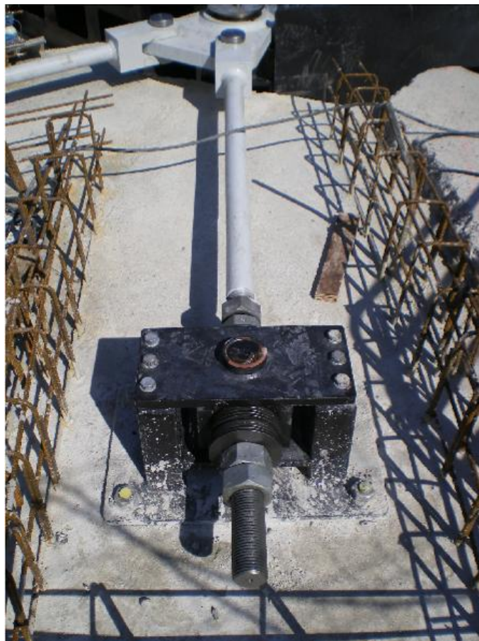
Figure 18 : Exemple de tirant élastique avec rondelles Belleville (grand gabarit)
