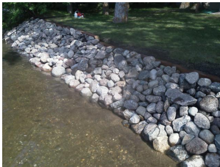
Figure 27 : exemple d'enrochement
