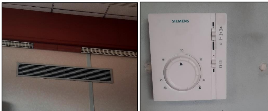
Mairie de la turbie / Bouche de soufflage ventilo-convecteur (à gauche) régulateur (à droite)
