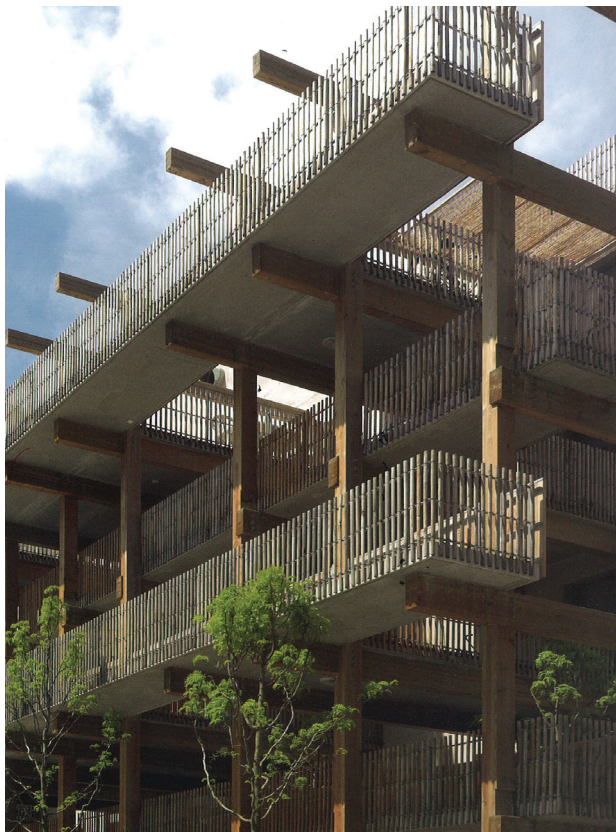
Des coursives désolidarisées de l'enveloppe du bâti pour supprimer les ponts thermiques : Grenoble (38) architecte : Edouard François
