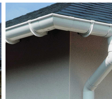
Gouttière rapporté : interdit
