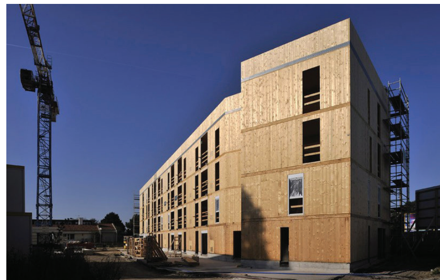
construction en bois massif - 2012 éco-quartier Henri Lesage, Vertou (44) architectes : FORMA 6
