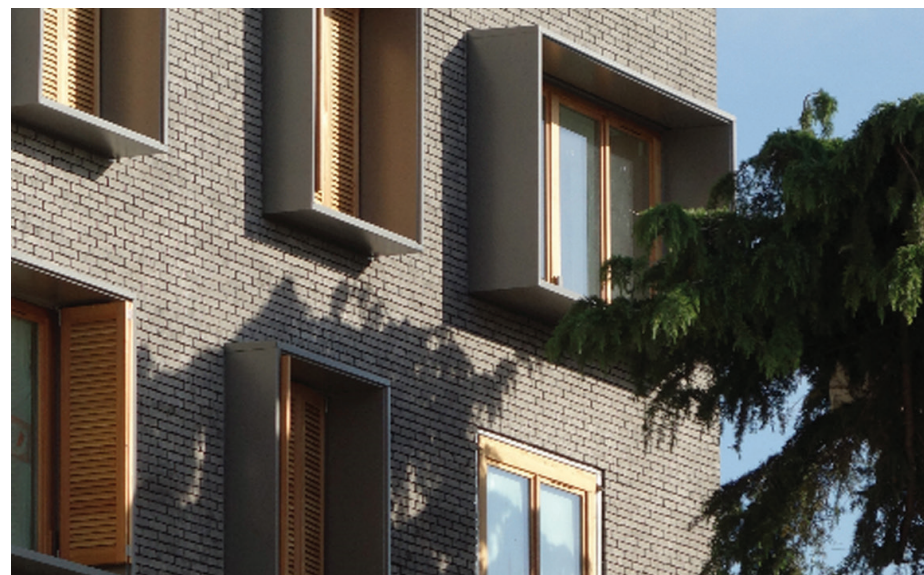
brique moulées main terres cuites logements collectifs Paris (75) architectes : Agence MG-AU – Michel Guthman
