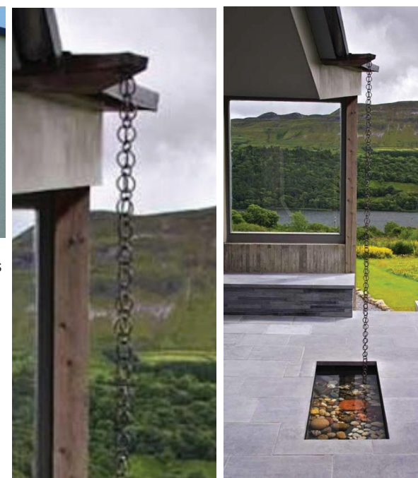
Descente d'eau pluviale à chaîne d'eau : à privilégier
