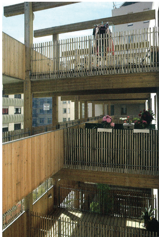
Des coursives désolidarisées de l'enveloppe du bâti pour supprimer les ponts thermiques : Grenoble (38) architecte : Edouard François
