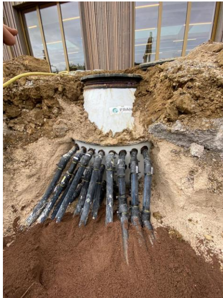
Collecteur enterré en regard et collecteur en local technique (source Enebat)
