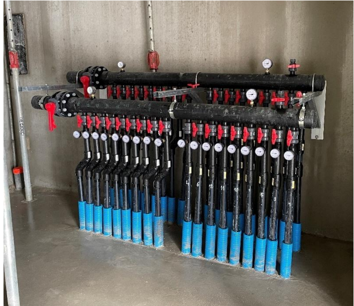
Collecteur enterré en regard et collecteur en local technique (source Enebat)
