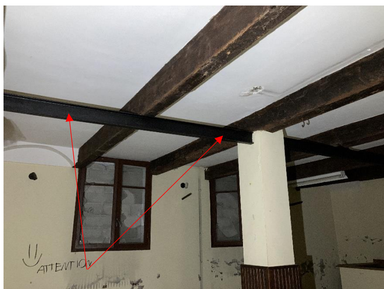
Figure 6 Vue des renforts de la zone plus enterrée
