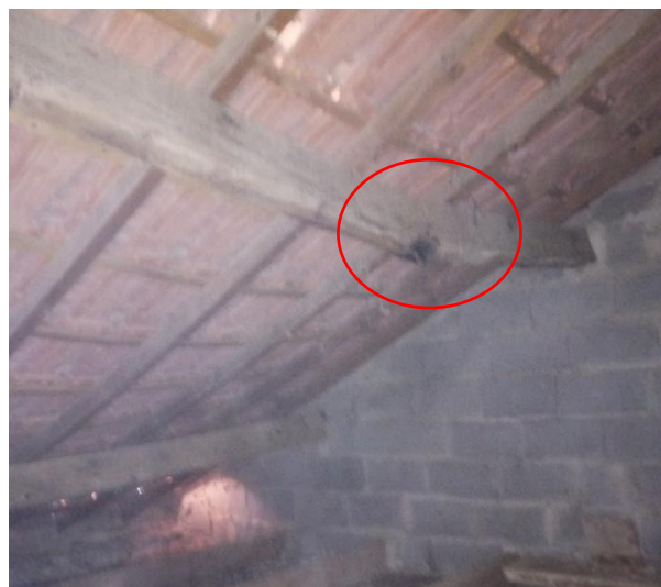
Poutre fracturée
