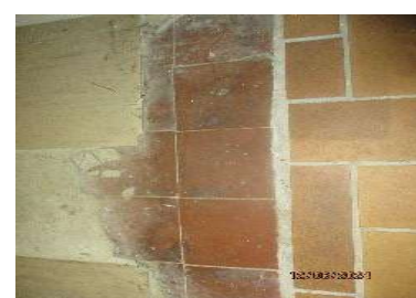
Ech 5 : Carrelage marron foncé + colle (sous ECH 6) sans amiante
