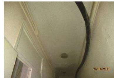
Ech 25 : Enduit plafond sans amiante
