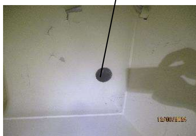
Photo 7 : ventilation haute en PVC sans amiante dans R+1 WC couloir 1
