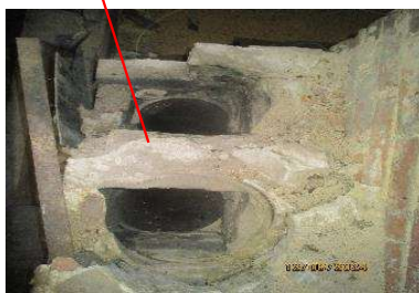
Ech 44 : Conduits de fumée en fibro-ciment amianté
