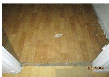
Ech 35 : Linoléum imitation parquet + colle (sous ECH 26) sans amiante
