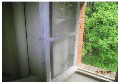
Ech 24 : Mastic fenêtre sans amiante
