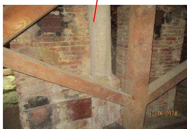
Ech 44 : Conduit de fumée en fibro-ciment amianté
