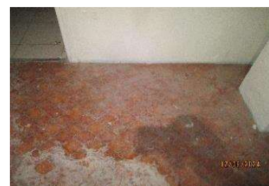
Ech 38 : Linoléum imitation carrelage + colle sans amiante
