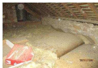
Ech 43 : Isolant + pare vapeur sans amiante
