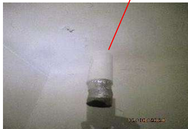
Ech 27 : Conduit de fumée en fibro-ciment amianté
