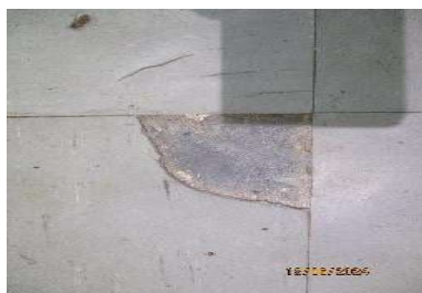
Ech 13 : Carrelage + colle (sous ECH 12) sans amiante
