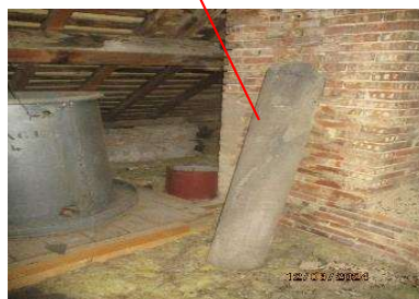
Ech 44 : Conduits de fumée en fibro-ciment amianté
