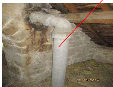
Ech 44 : Conduits de fumée en fibro-ciment amianté
