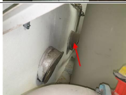
Photo n° conduit fibro ciment Localisation : Sous-Sol B - Chauffage
