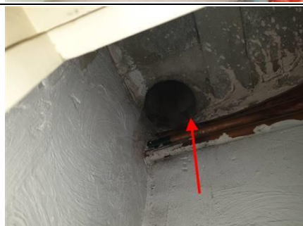
Photo n° conduit fibro ciment Localisation : 5ème étage B - Local technique A
