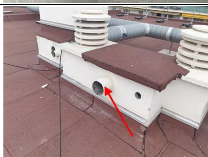
Photo n° conduit fibro ciment Localisation : 5ème étage B - Toit terrasse
