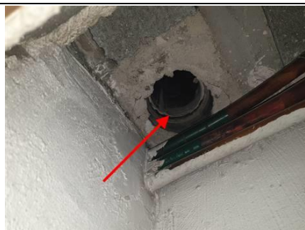
Photo n° conduit fibro ciment Localisation : 5ème étage A - Local technique B
