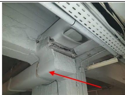
Photo n° conduit fibro ciment Localisation : Sous-Sol C - Allée garages
