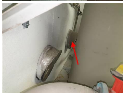
Photo n° conduit fibro ciment Localisation : Sous-Sol B - Chaufferie
