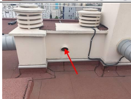
Photo n° conduit fibro ciment Localisation : 5ème étage A - Toit terrasse
