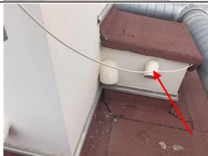
Photo n° conduit fibro ciment Localisation : 5ème étage A - Toit terrasse
