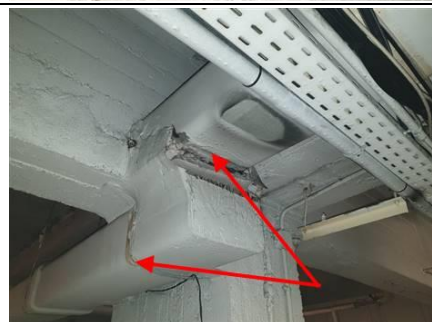
Photo n° conduit fibro ciment Localisation : Sous-Sol B - Allée garage
