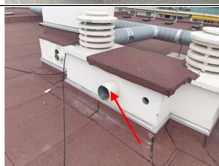
Photo n° conduit fibro ciment Localisation : 5ème étage B - Toit terrasse
