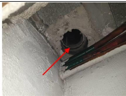
Photo n° conduit fibro ciment Localisation : 5ème étage A - Local technique B
