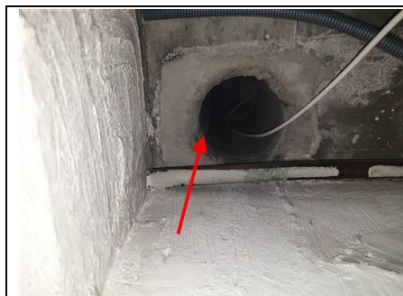
Photo n° conduit fibro ciment Localisation : 5ème étage A - Local technique C
